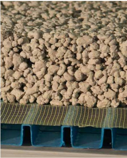
Prinzip der kapillarpassiven Flächendrainage am Beispiel des Systems AquaDrain EK in Kombination mit Drainmörtel. | Alle Fotos: Gutjahr
