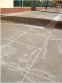
Natursteinbelag, verlegt im klassischen Mörtelbett auf Abdichtung. Stauwasser in der Konstruktion führte schon nach 6 Monaten zu irreparablen Schäden am Belag.
